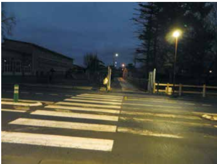
Eclairage renforcé du passage protégé au abords de l'école.
