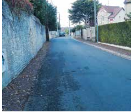
Rue Grange Denis : réfection de chaussée
