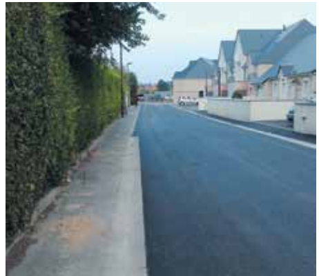
Rue du Moulin : réfection de chaussée
