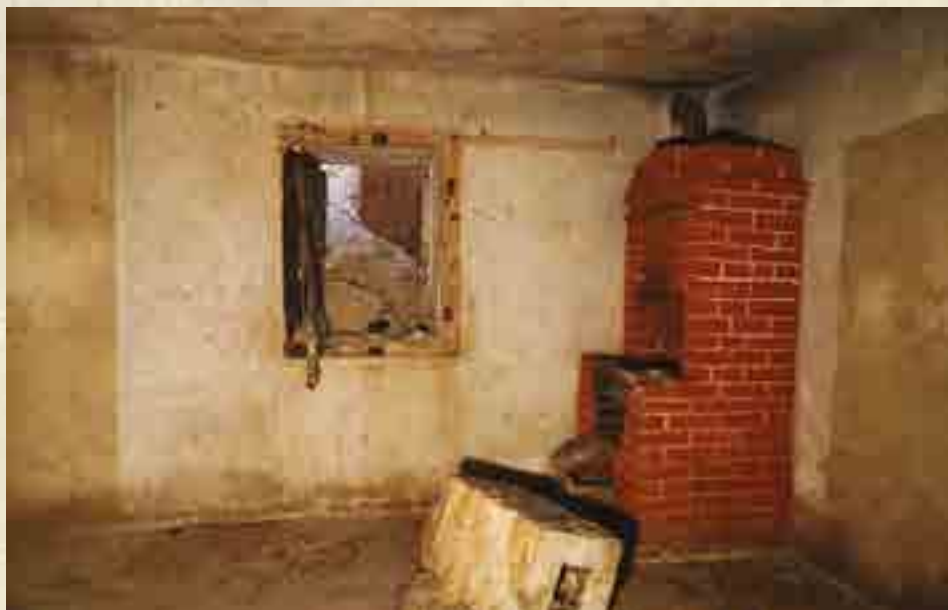
Vue d'un poêle en brique qui a conservé sa porte de foyer, son tiroir à cendre et son tuyau d'évacuation des fumées. La maçonnerie couchée sur le sol est un morceau de la cheminée extérieure qui a été « balancée » là lorsque l'abri a été remblayé. L'ouverture dans le mur est une trappe de sortie de secours. En cas de danger, les soldats avaient la possibilité de sortir par derrière et de regagner la surface à l'aide d'une échelle.
