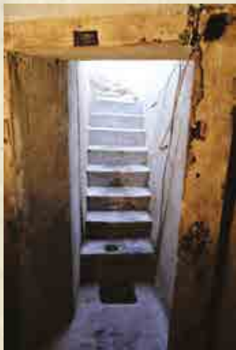
Escalier et porte d'accès d'un abri.
