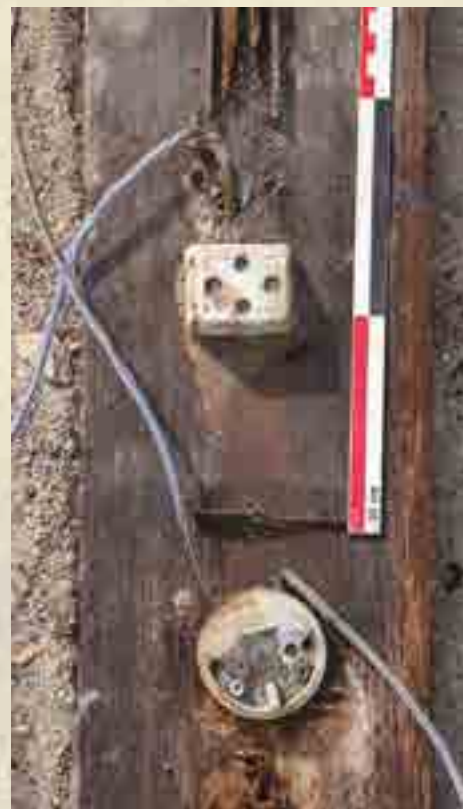
Boiserie d'encadrement de porte d'entrée avec les restes d'une installation électrique, prise et interrupteur.
