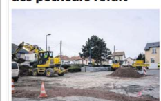
Les travaux doivent se terminer à la fin du mois d'avril.
